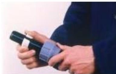
4. Вставить трубу, продвигая зажимное кольцо до достижения упоров внутри тела фитинга. (Наиболее частая ошибка при монтаже – труба вставляется до разрезного кольца, а не до упора. Требуется немного нажать и вставить трубу до упора.).
